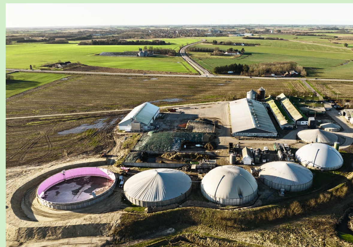
Et biogasanlæg som Thomas Kjær producerer naturgas til danskerne af gylle og tørstof som overskydende halm fra markerne.
